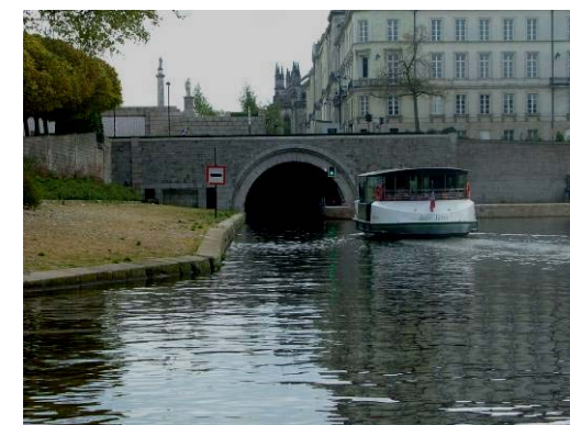
Figure 12 : Echelle limnimétrique, Ecluse et Tunnel de Saint-Félix
