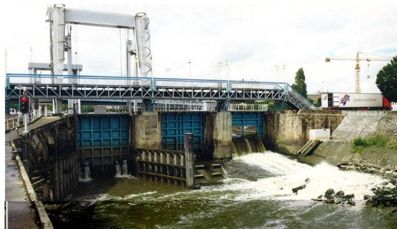
Figure 90 : Ecluse de Saint-Félix (côté Loire, en aval)
