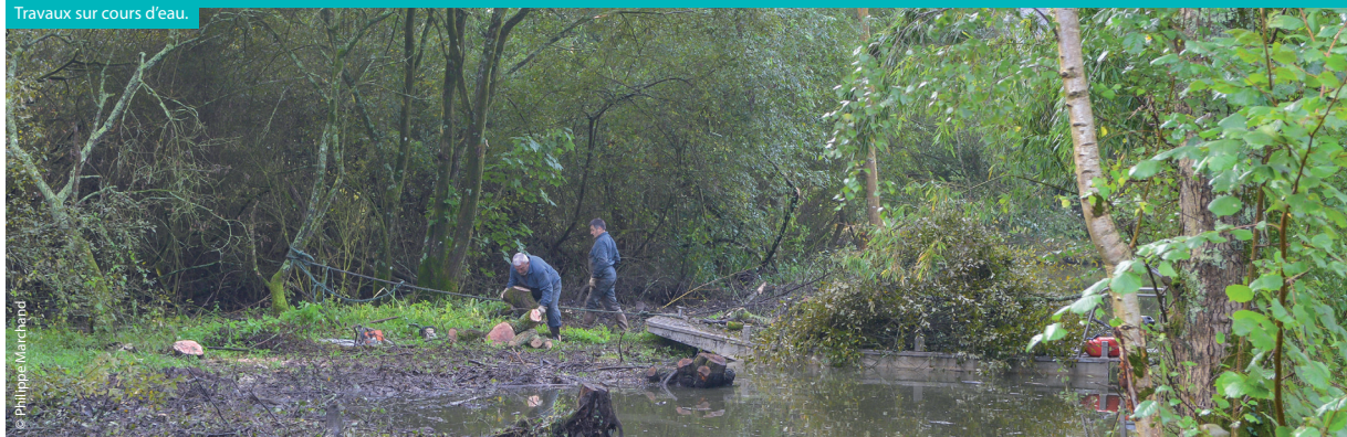
Travaux sur cours d'eau.
