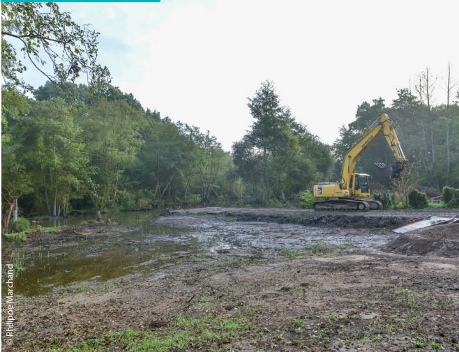
Travaux sur les marais de l'Erdre.
