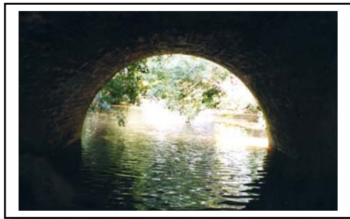
Pont du Verdier
