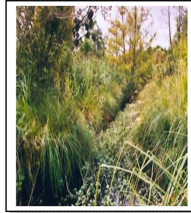
Fermeture d'une douve par la végétation
