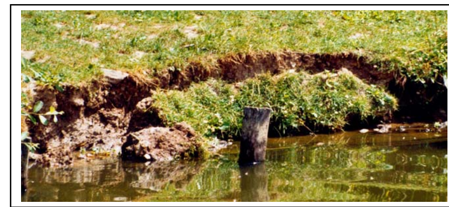
Berge dégradée sur les bords de l'Erdre
