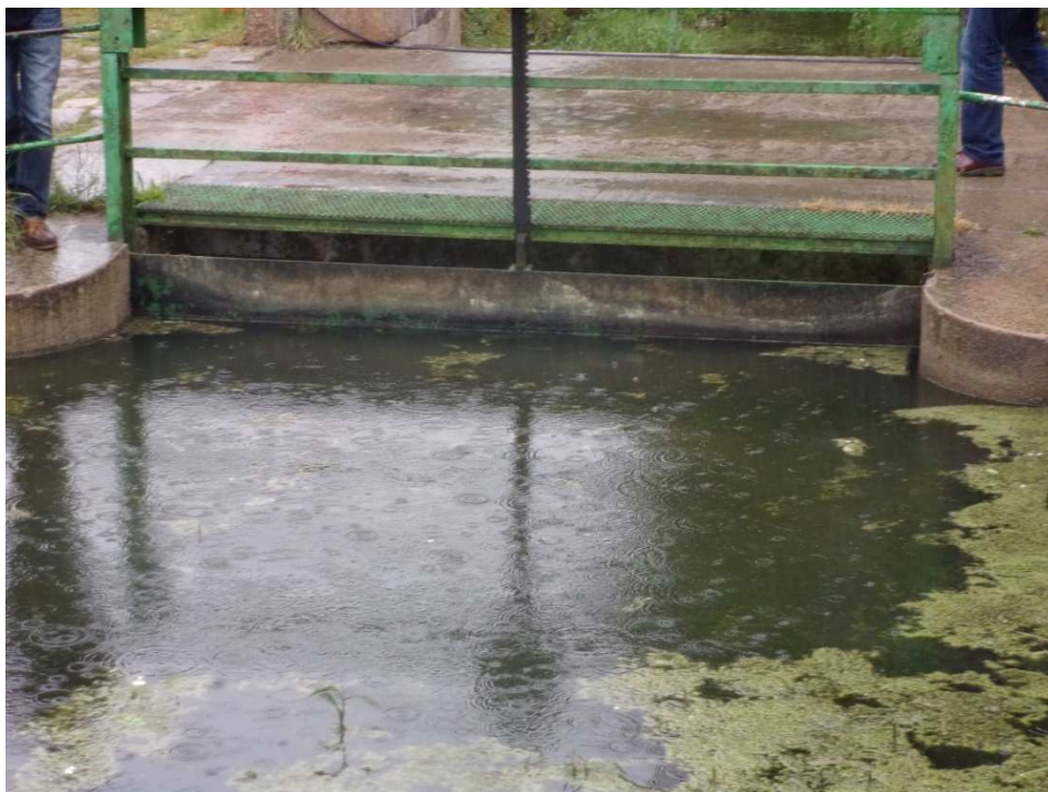
Photo 5 : Vue du déversoir de crue du barrage de Vioreau (niveau de remplissage maximal)
