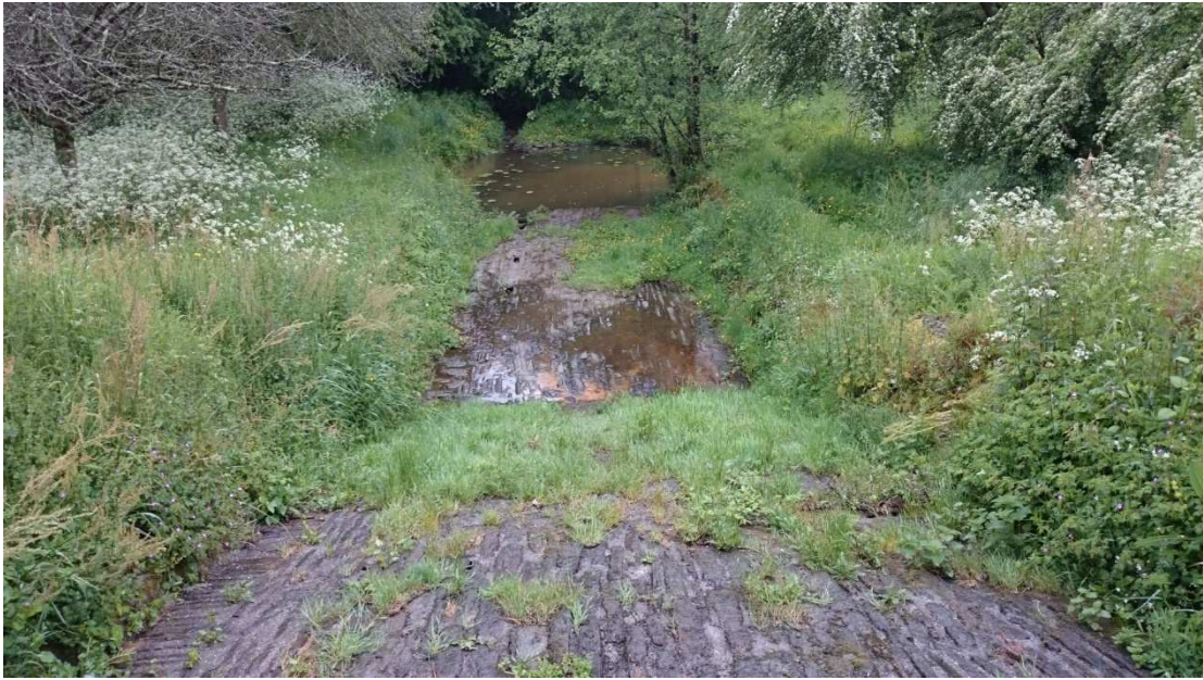
Photo 7 : Déversoir d'écoulement des eaux de la retenue vers le ruisseau le Baillou
