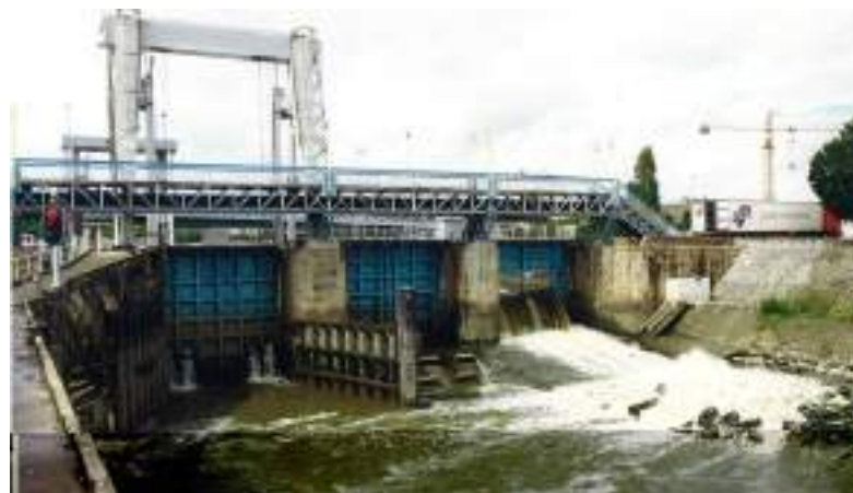
Figure 90 : Ecluse de Saint-Félix (côté Loire, en aval)
