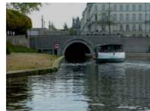
Figure 12 : Echelle limnimétrique, Ecluse et Tunnel de Saint-Félix
