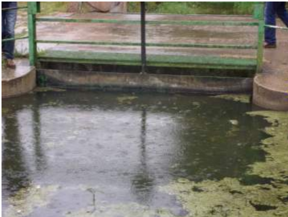
Photo 5 : Vue du déversoir de crue du barrage de Vioreau (niveau de remplissage maximal)
