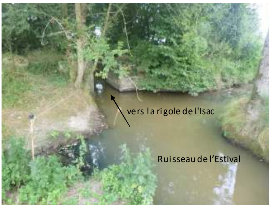
Photo 3 : Vue de la jonction entre le ruisseau de l'Estival et la rigole (ancien vannage) de l'Isac
