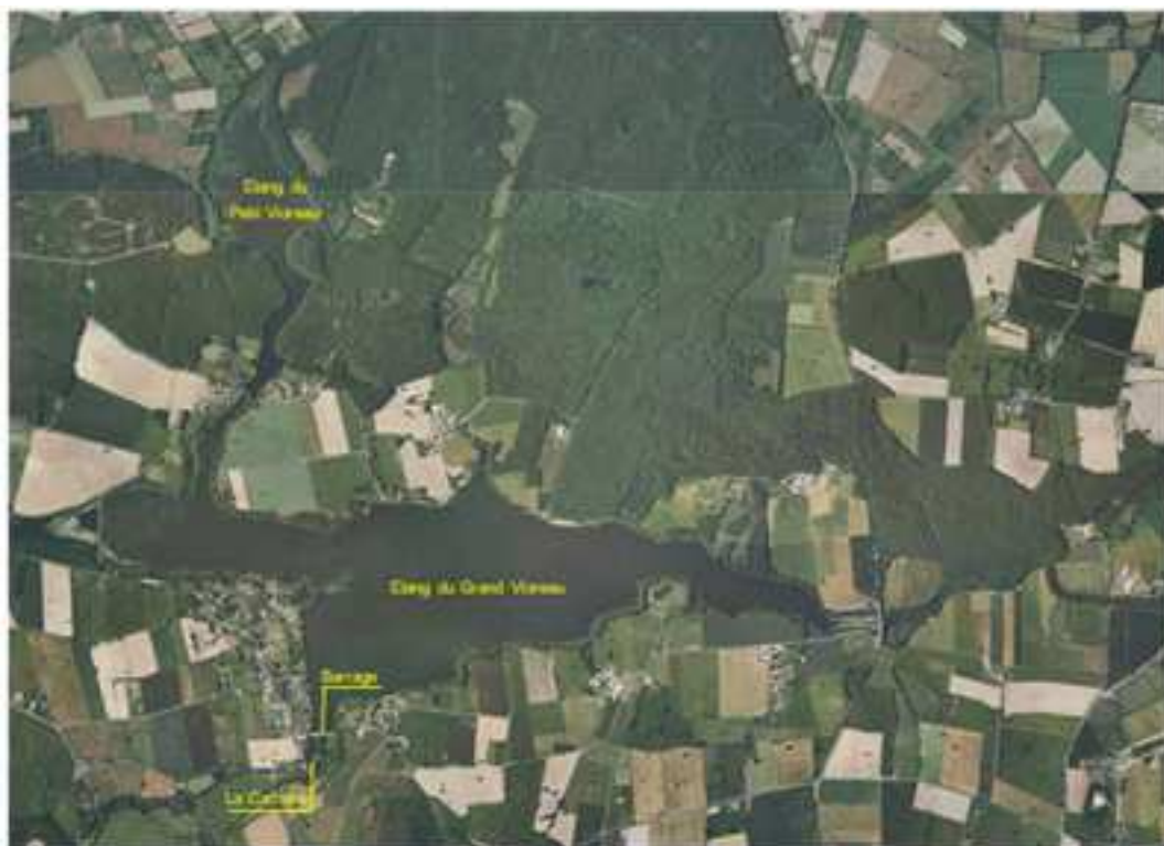
Figure 21 : Vue aérienne du grand réservoir de Vioreau (source Géoportail)
