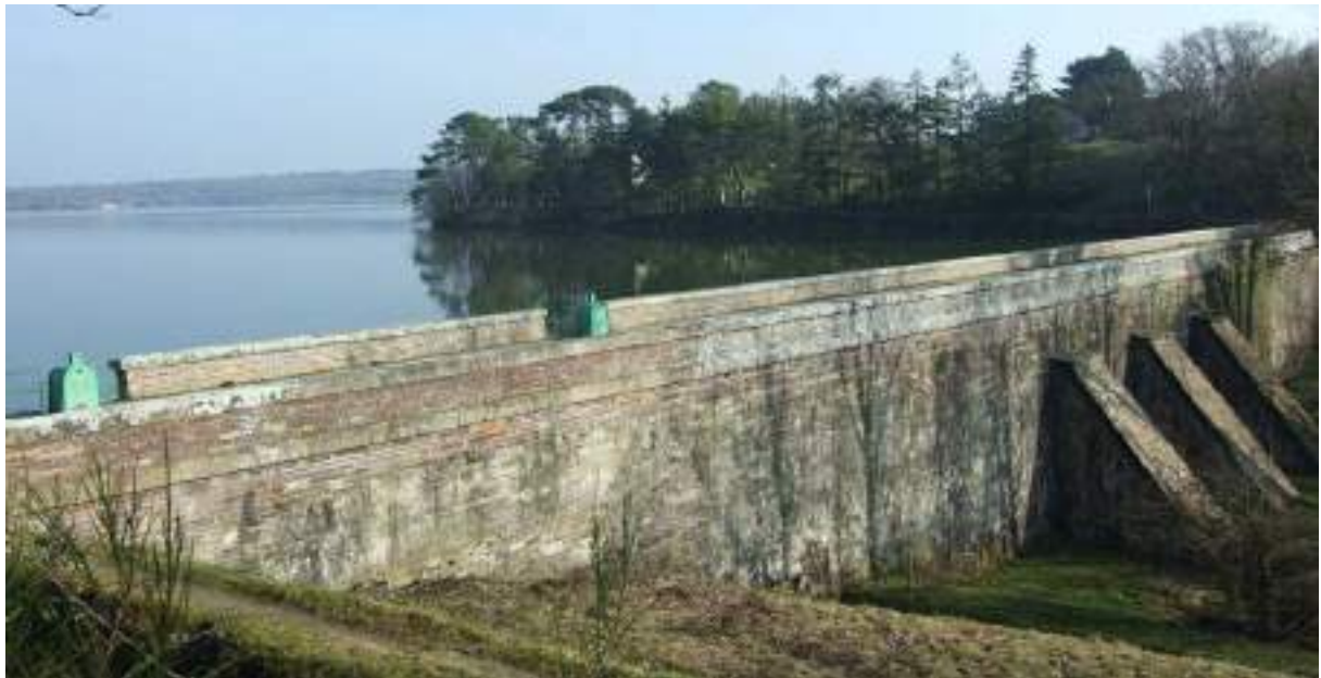
Photo 4 : Vue du parement aval du barrage de Vioreau (2016)
