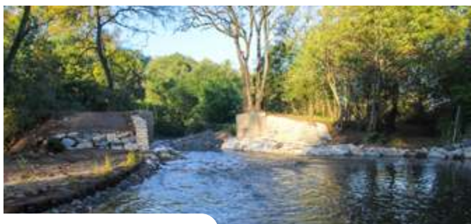
Le moulin de Vault après travaux
