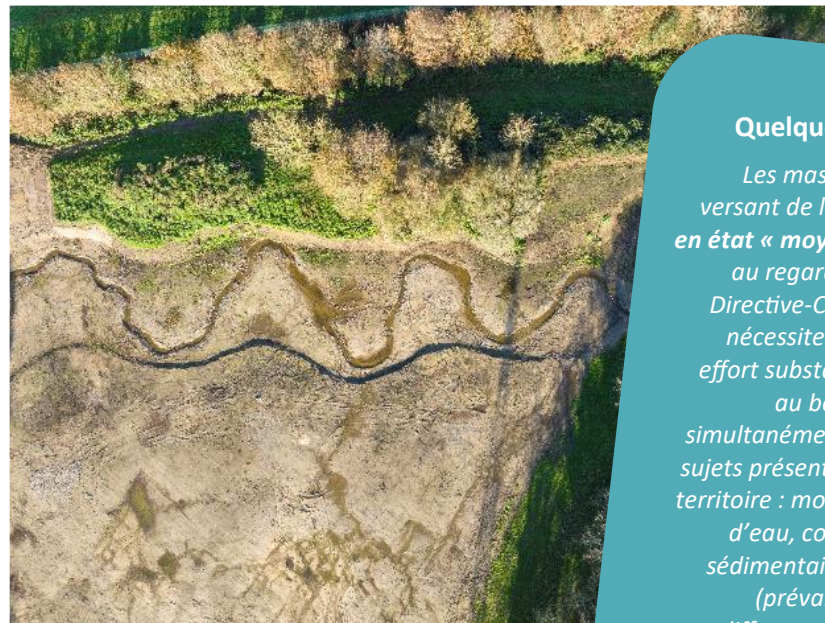
Reméandrage et restauration de zones humides sur le ruisseau du Ménardais - travaux 2023, Nantes Métropole
